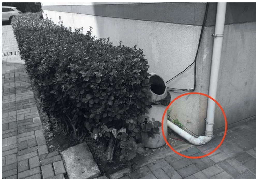
图 7 住户自发将雨落管末端延伸至宅旁绿地
