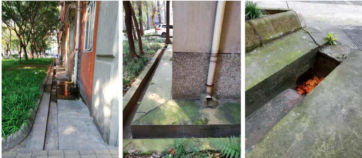
图 10 成都的建筑散水做法
